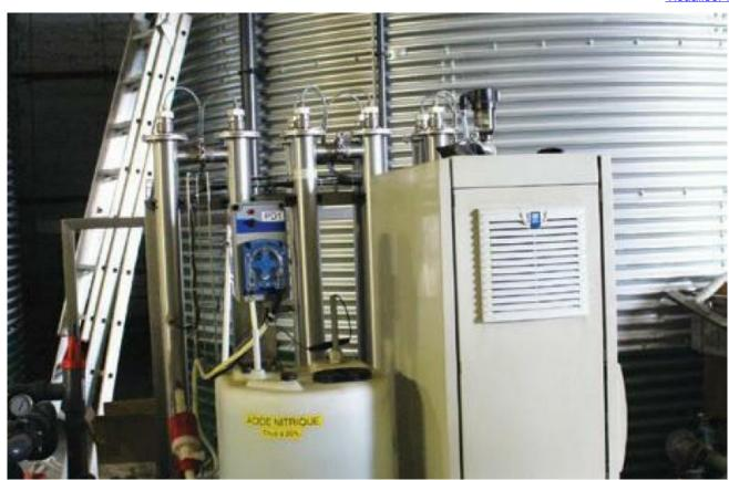
UNE STATION UV PERMET DE DÉSINFECTER L'EAU DE DRAINAGE afin de la réinjecter dans le circuit de ferti-irrigation. © M. LE CORRE
